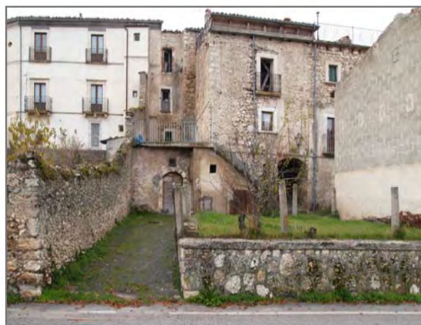
Spazi aperti a ridosso della cinta muraria
